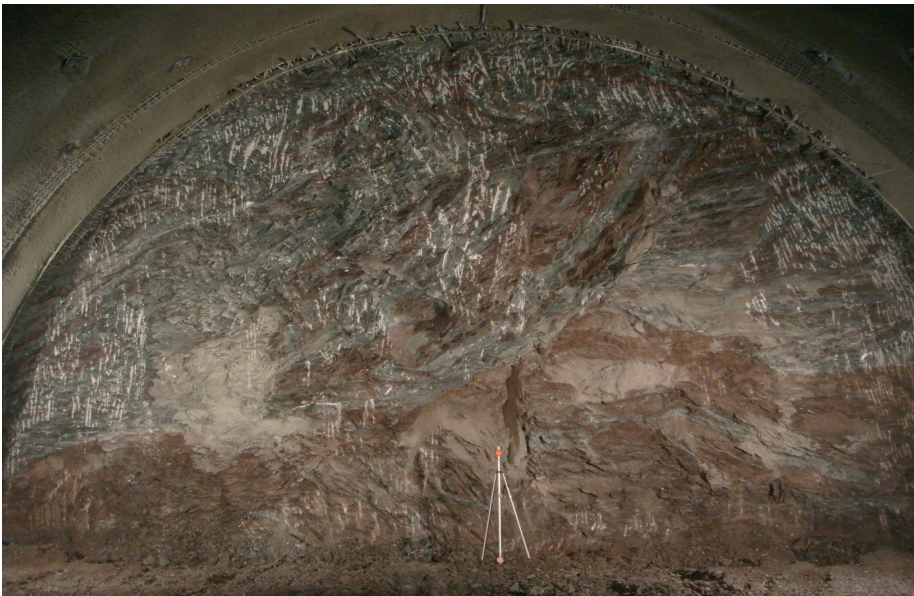
Abb. 6: Beispiel einer typischen Ortsbrust (Station 620,10 m) in der Hütteldorf-Formation (Blickrichtung Südost) und geologische Dokumentation der Ortsbrust (Station 620,10 m) in der Hütteldorf-Formation angefertigt von Gerhard Koch (Büro Bechthold).
